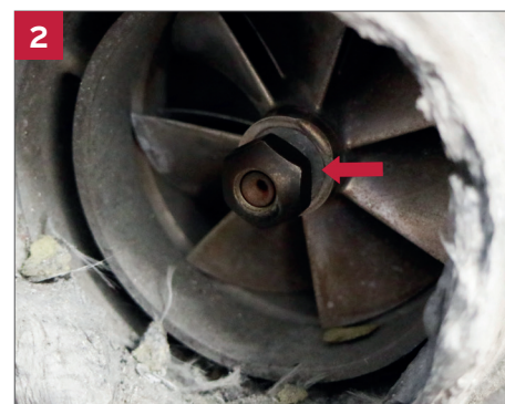
2 Wellenmutter durch Schmierungsmangel locker gedreht
