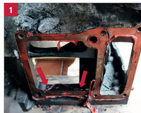
1 Massive Dichtungsreste am Motorblock gelangten ins Öl
